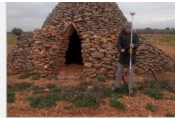
Villarrobledo-España Levantamiento topográfico de Bombo: construcción rural tradicional concebida para alojar en ella a pastores y labradores junto con sus animales de labor y sus aperos de labranza
