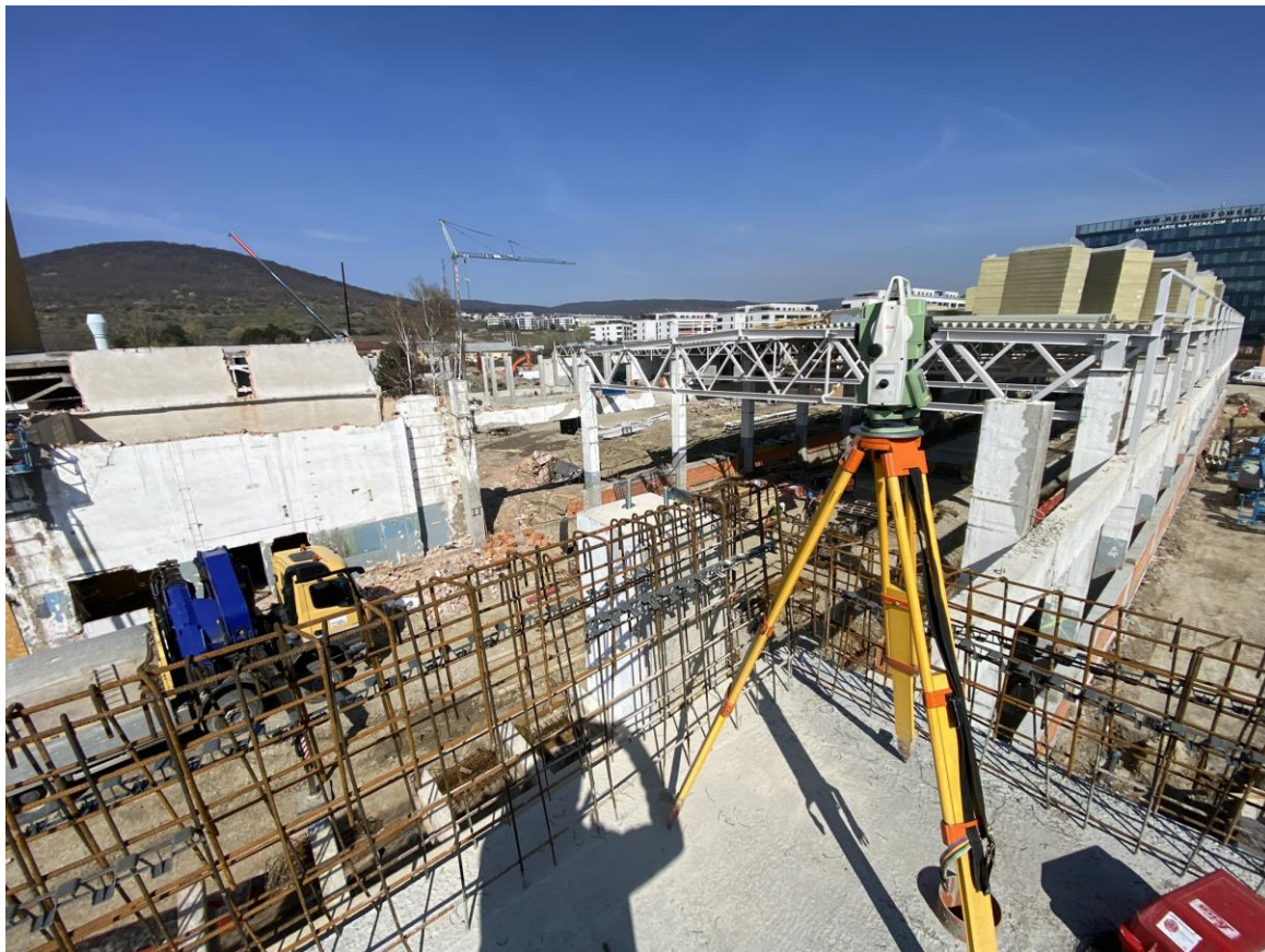
Obr. 8 a 9 – Vytyčovanie novej ocelevej konštrukcie strechy
