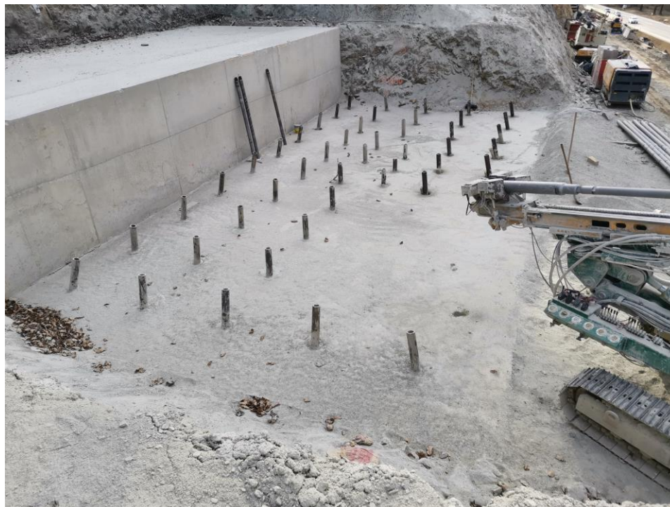
Vytýčenie a vŕtanie mikropilot
