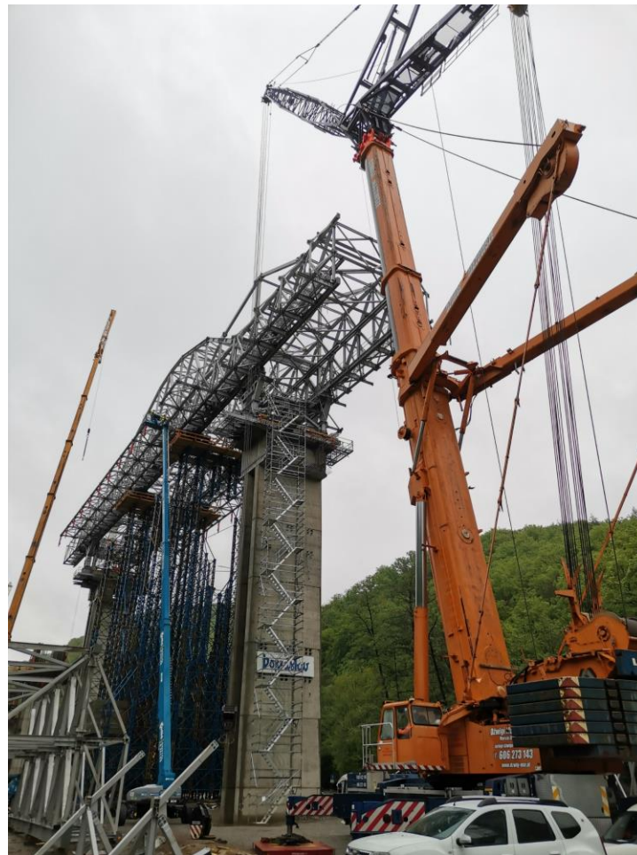
Zdvih a spájanie dielov výsuvnej skruže BERD
