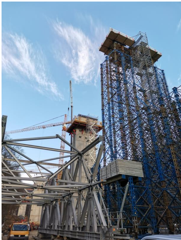
Montáž podpornej konštrukcie
