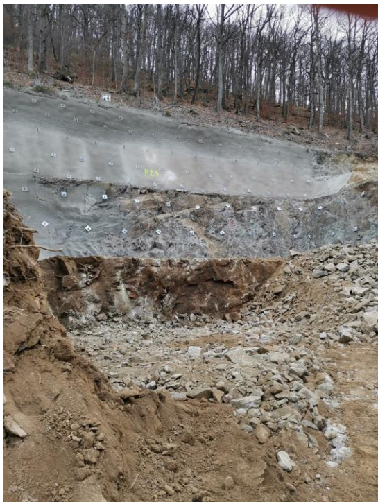
Zakladanie spodnej stavby
