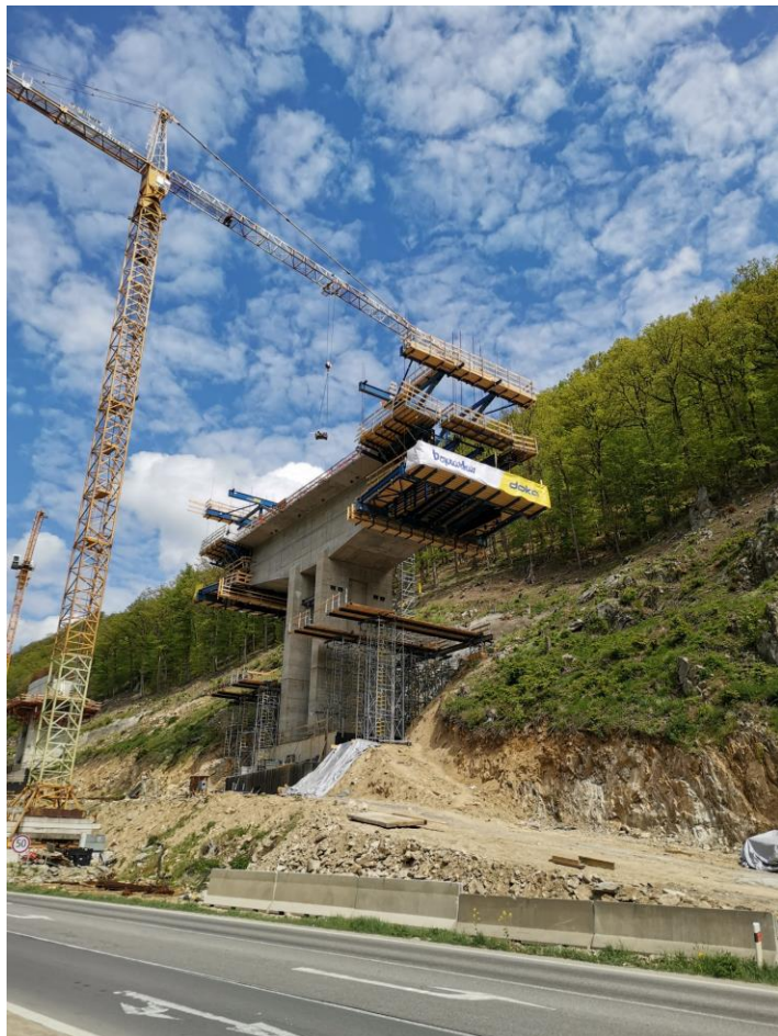
Letmá betonáž pomocou vozíkov
