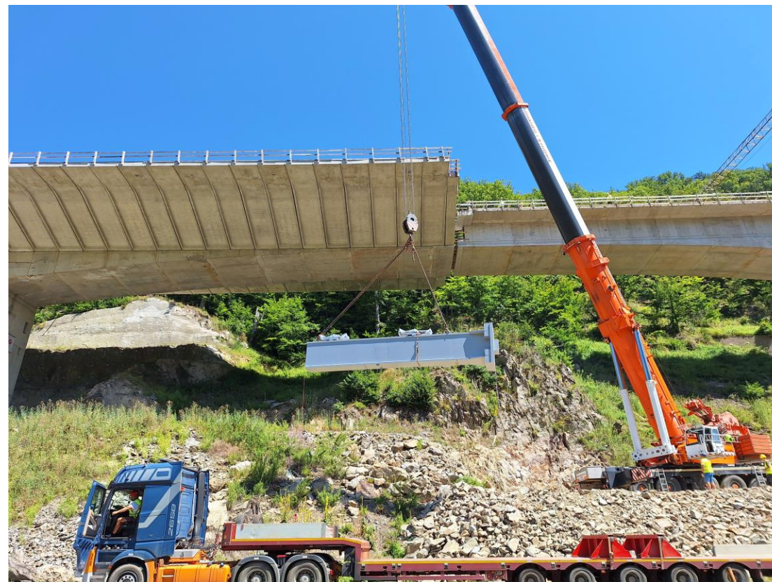
Osádzanie váhadla SO209-01 DC3 a SC4
