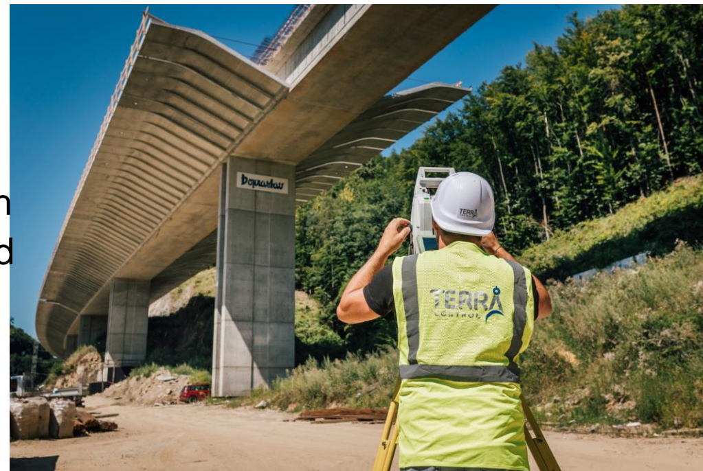
Kontrolné zameranie vzpier po osadení
