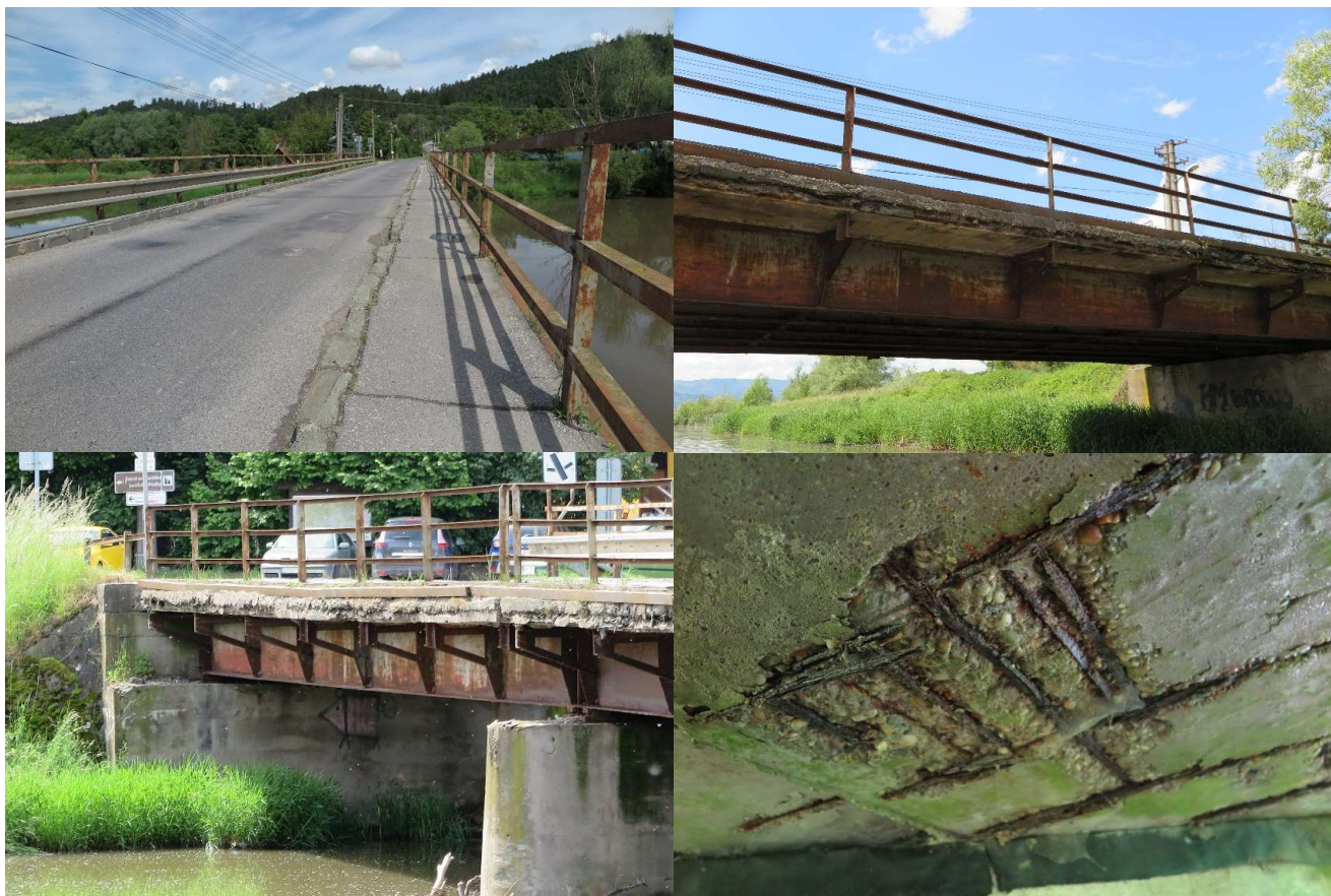
Fotodokumentácie mosta č. 2420 Šalková
