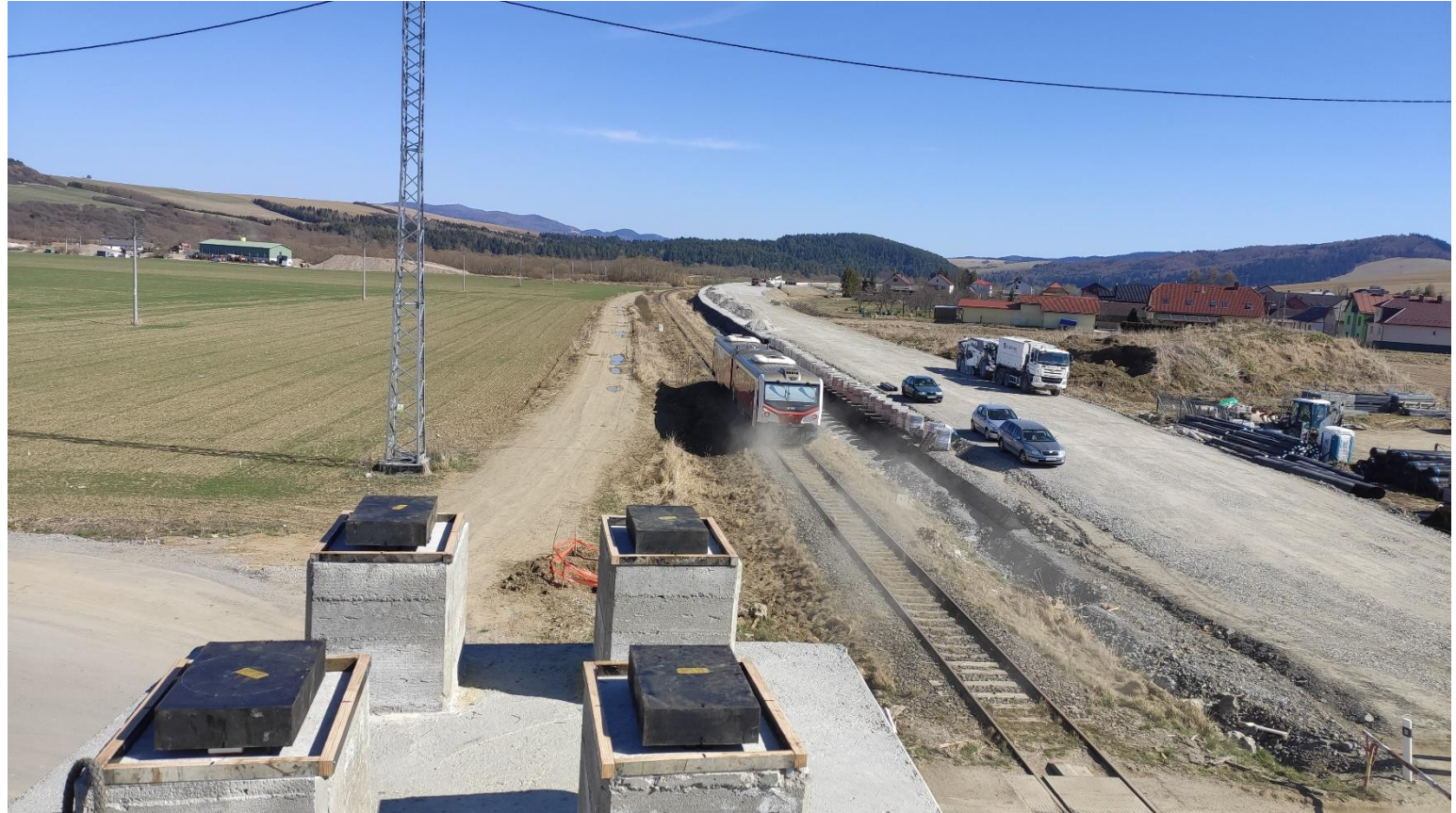
SO 206-00 Most na ceste III/543 032 nad cestou I/68 a traťou ŽSR v km 4,622
