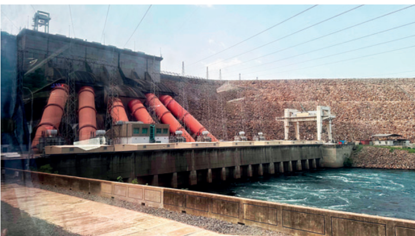
Obr. 8 • Hrádza priehrady Akosombo Dam na rieke Volta
