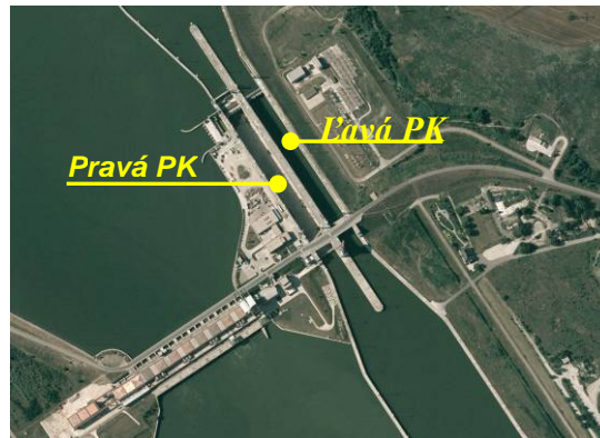
Obr. 1. Plavebné komory vodného diela Gabčíkovo – Nagymaros, stupeň Gabčíkovo
