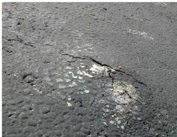
Obr. 3 Vypuklina na AB plášti
