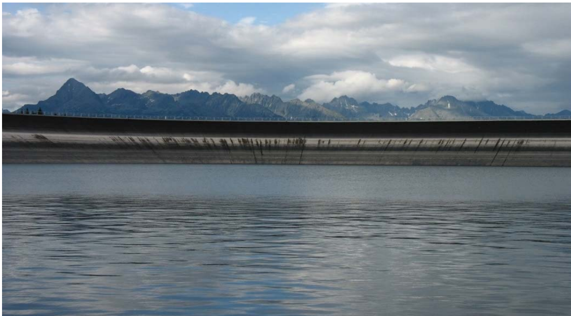
Obr.1 Pohľad na zníženú hladinu vody v hornej nádrže PVE Čierny Váh
