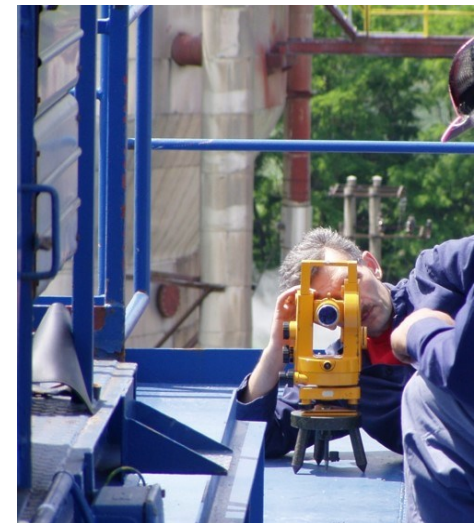
Upevnenie prístroja na pilierovej podložke
