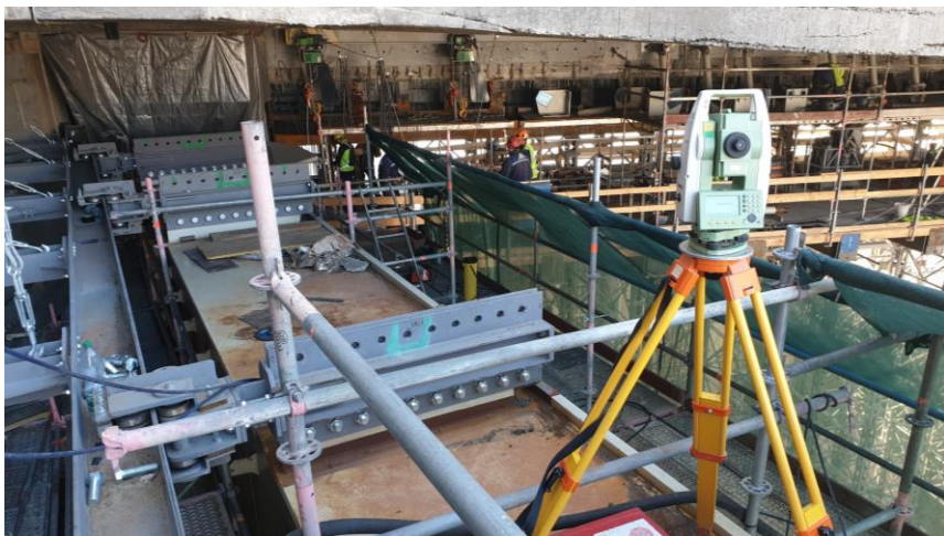
Obr. 16 – Kontrolné meranie počas montáže horného oporného prahu
