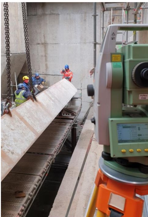
Obr. 26 – Kontrolné meranie pri montáži dolného nosníka
