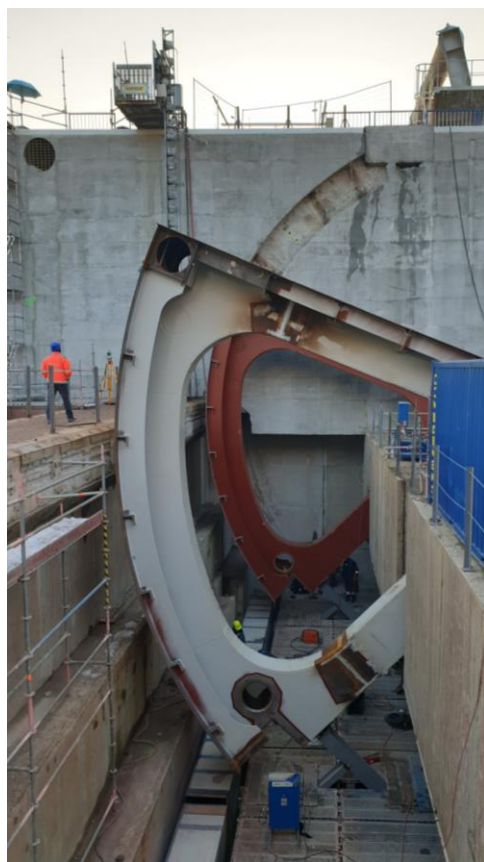
Obr. 27 – Kontrolné meranie pri montáži hlavných nosníkov
