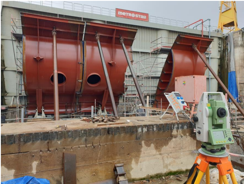
Obr. 34 – Kontrolné meranie pri montáži ocelevej konštrukcie telesa klapky
