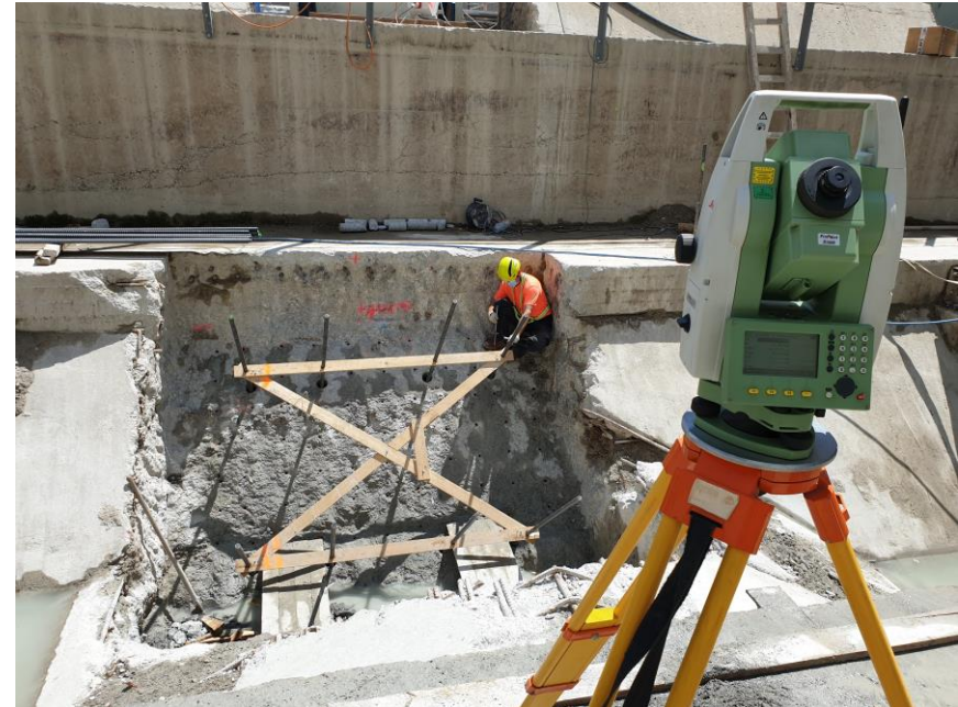
Obr. 33 – Kontrolné meranie kotvenia konzol ložísk hydraulických valcov
