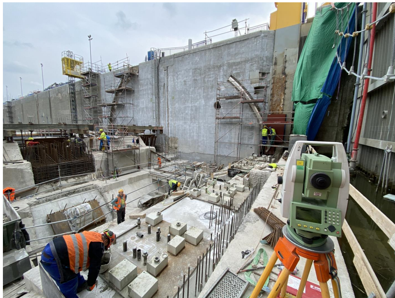
Obr. 31 – Geodetické práce na klapke
