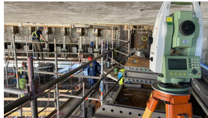
Obr. 18 – Kontrolné meranie počas montáže horného oporného prahu
