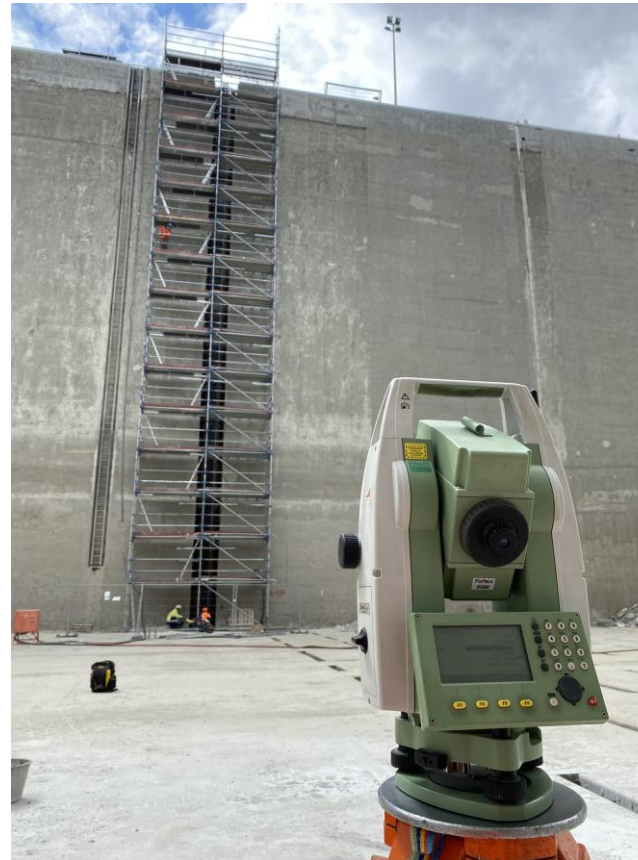
Obr. 39 – Zameranie ocelevej konštrukcie drážky
