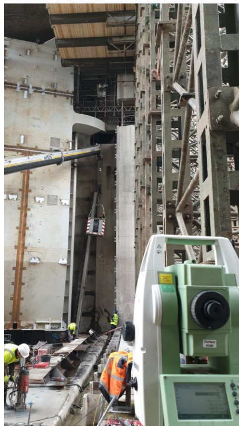
Obr. 17 – Kontrolné meranie počas montáže bočného tesnenia
