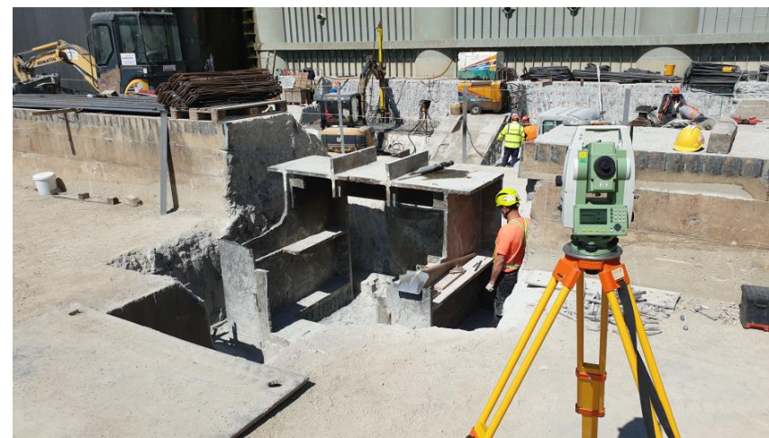
Obr. 22 – Vytýčenie búracích prác
