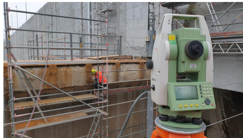
Obr. 24 – Vytýčenie kotvenia dolného tesniaceho prahu
