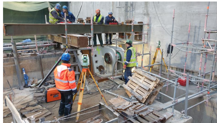
Obr. 25 – Kontrolné merania pri montáži ložiskových konzol
