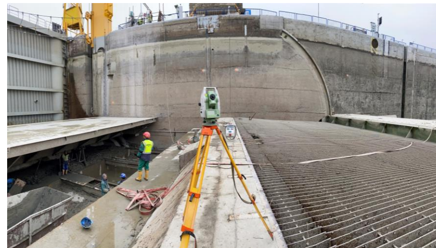
Obr. 21 – Zameranie existujúcich konštrukcií
