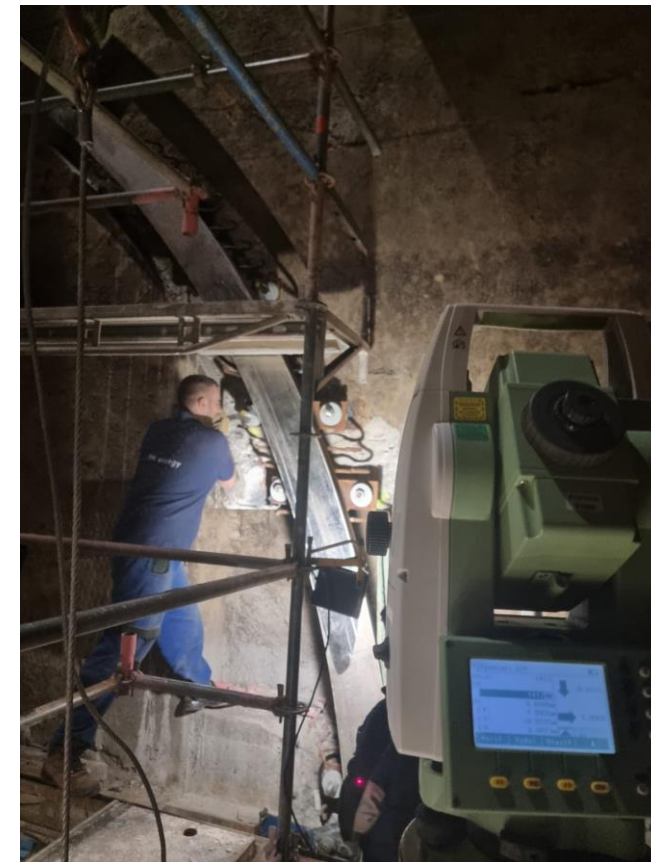
Obr. 38 – Kontrolné merania pri montáži armatúry muriva horného bočného vedenia
