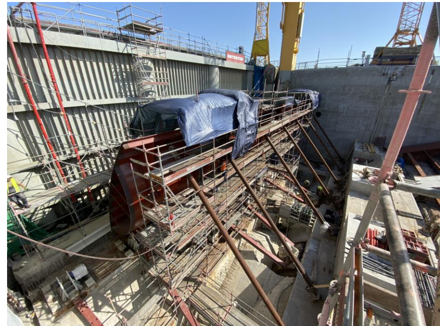
Obr. 35 – Kontrolné meranie pri montáži ocelevej konštrukcie telesa klapky
