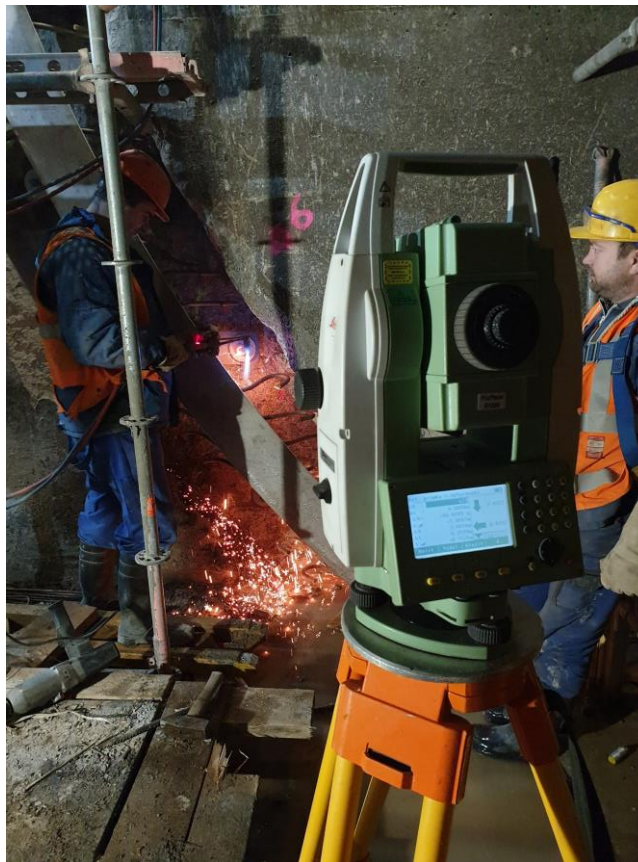
Obr. 37 – Kontrolné merania pri montáži armatúry muriva dolného bočného vedenia
