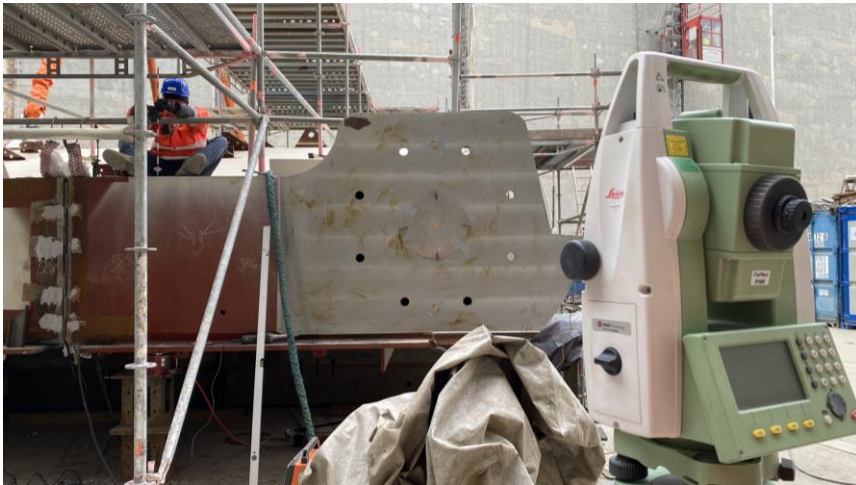
Obr. 12 – Kontrolné meranie na montážnom rošte
