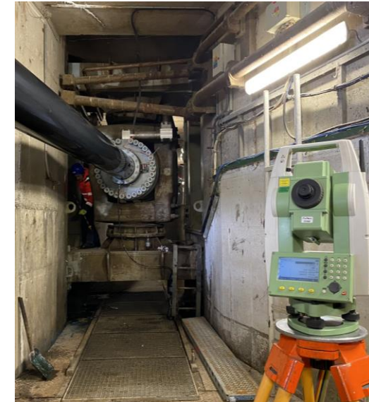
Obr. 11 – Hydraulický valec
