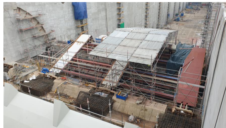
Obr. 28 – Kontrolné meranie rozmerov ocelevej konštrukcie počas montáže
