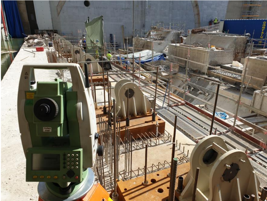
Obr. 32 – Kontrolné meranie pri montáži konzol ložísk klapky
